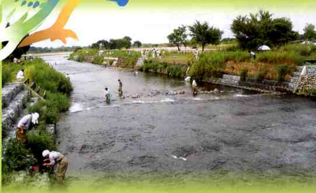
岐阜県自然共生工法展示場（岐阜県各務原市川島）
