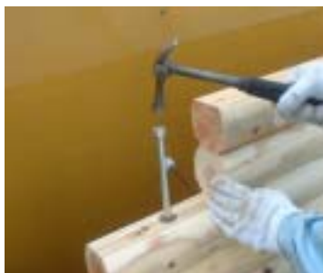
組立は連結金具を打込むだけです
