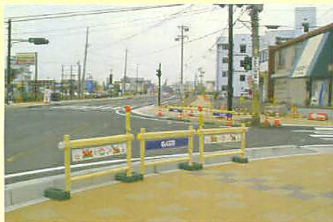
道路街路整備事業・大垣市内
